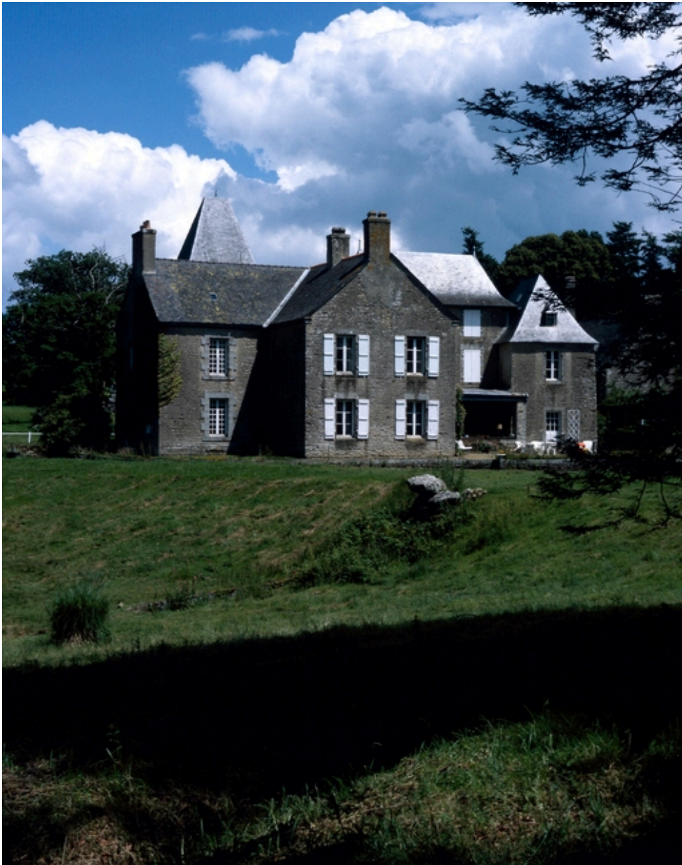
Château, vue générale sud-ouest.
