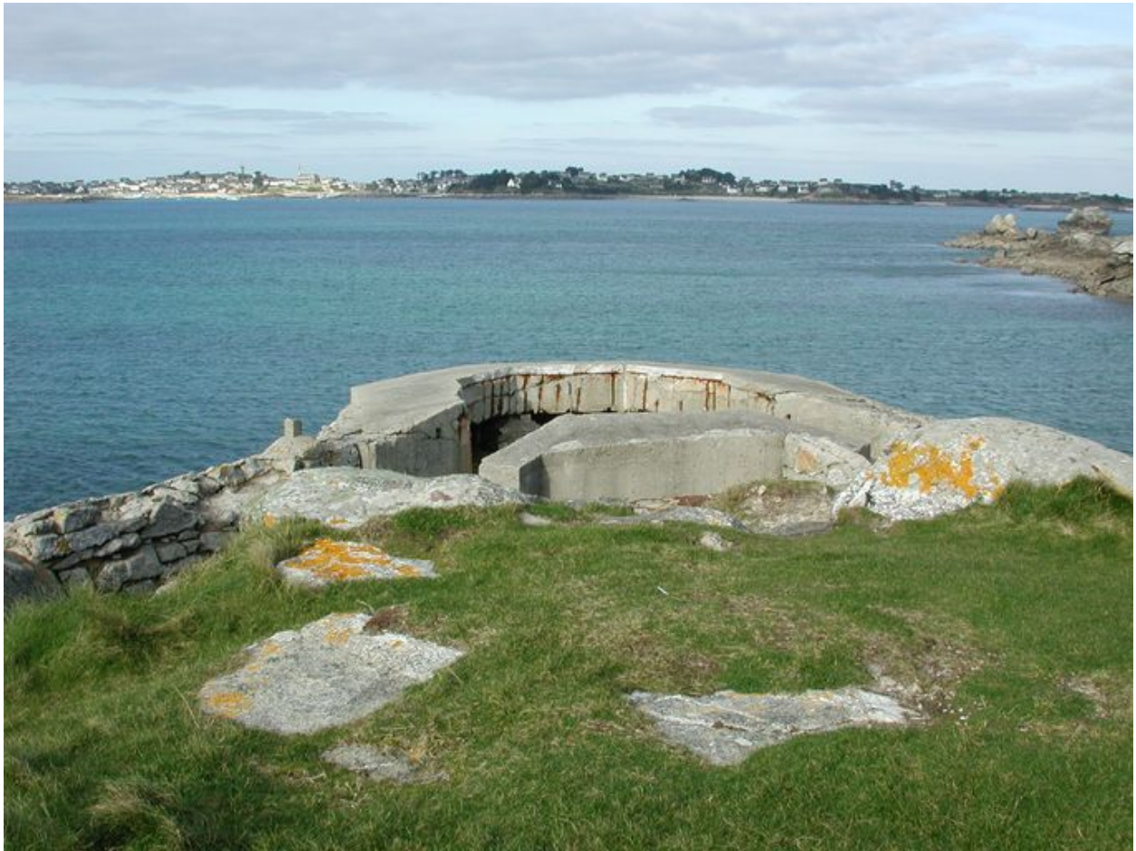
Vue générale de l'encuvement pour pièce de 40 mm de la pointe de Perharidi depuis l'ouest, en arrière plan l'île de Batz
