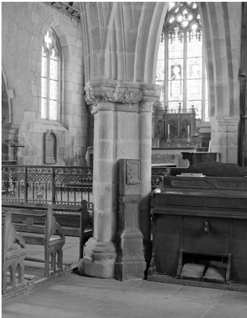
Pilier de la dernière travée du collatéral sud
