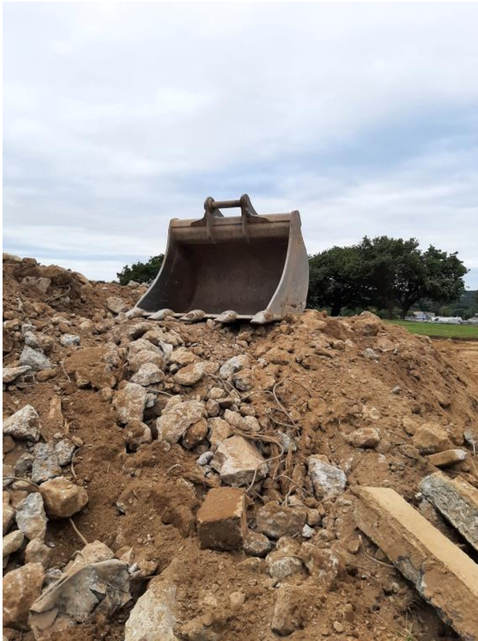
Vue de la déconstruction : godet utilisé par l'engin de terrassement (4 octobre 2022)
