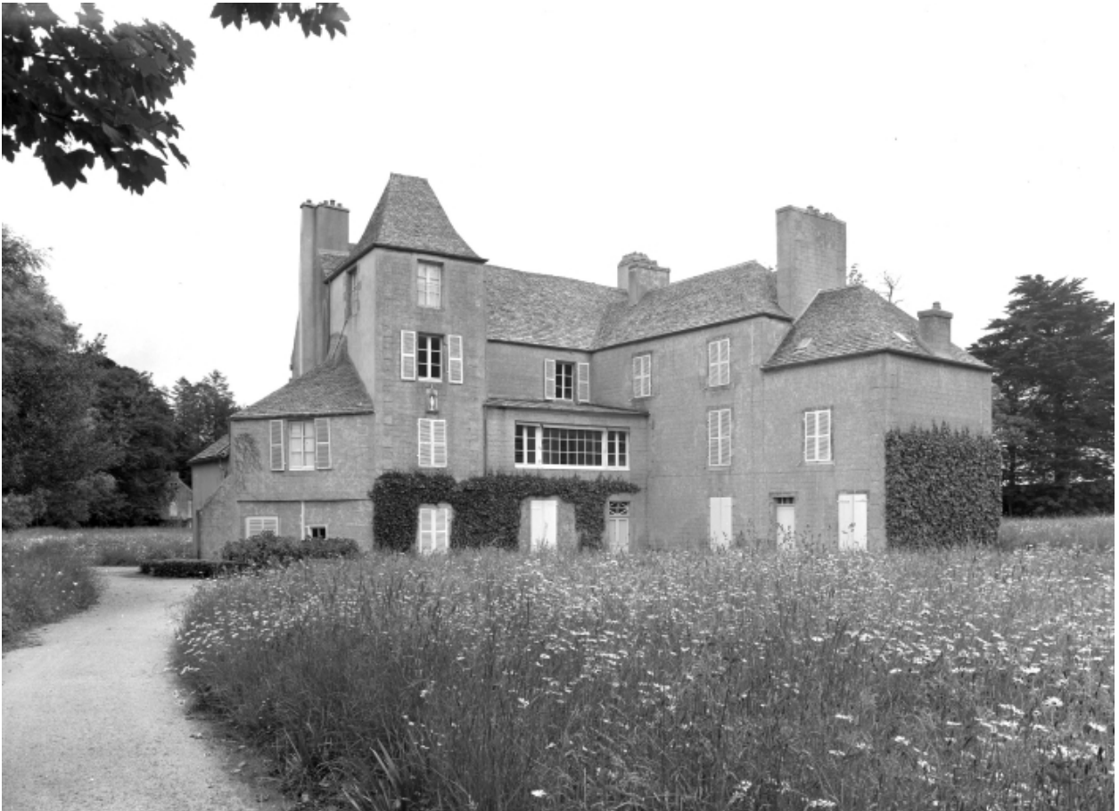
Logis, élévation ouest, vue générale
