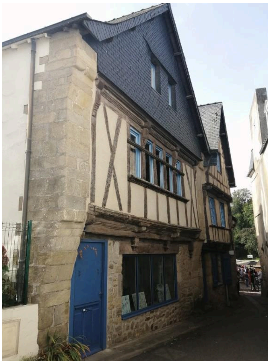
Façade en pan de bois avec encorbellement sur solives.
