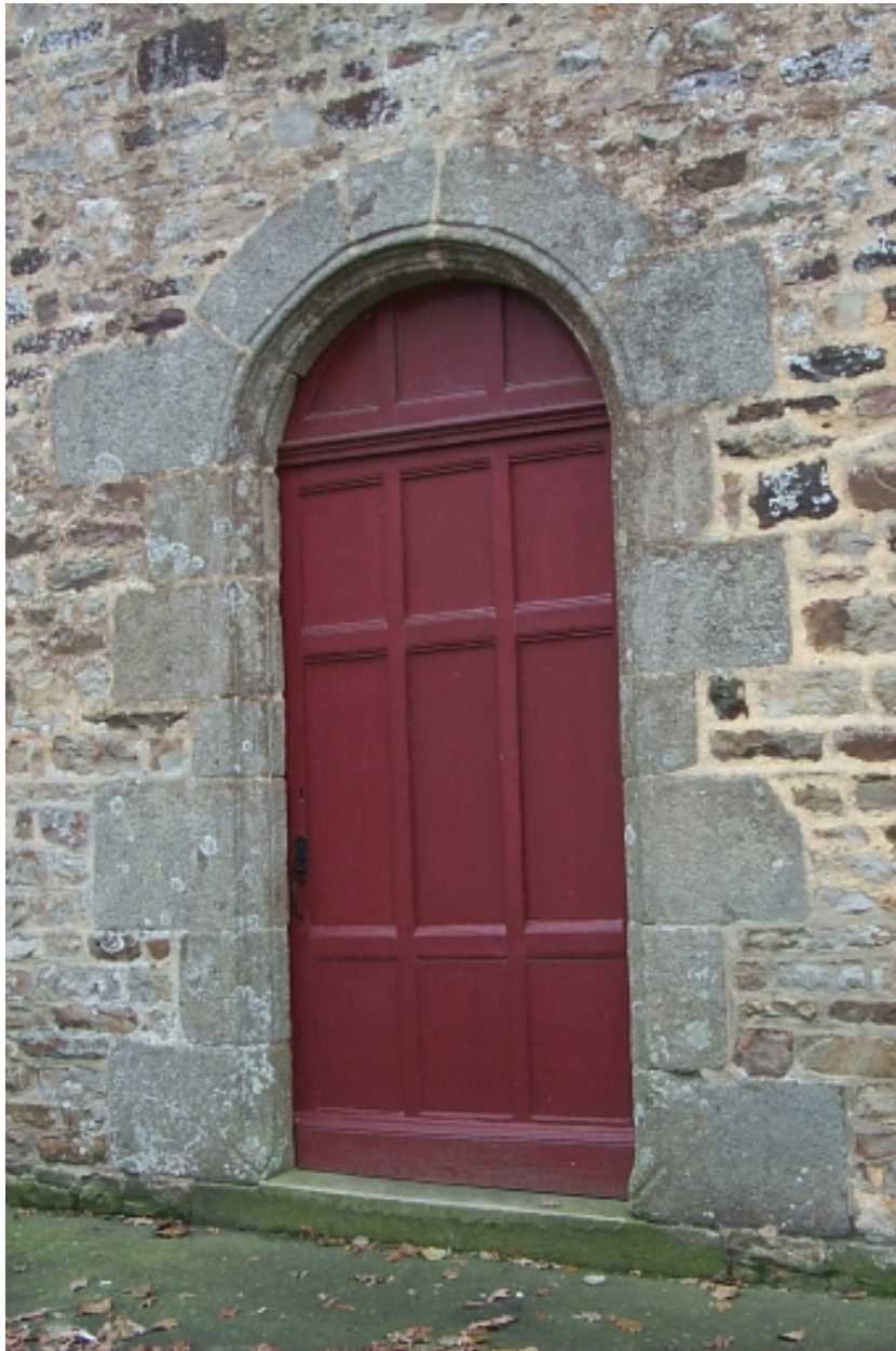
Porte ancienne employée dans la façade nord
