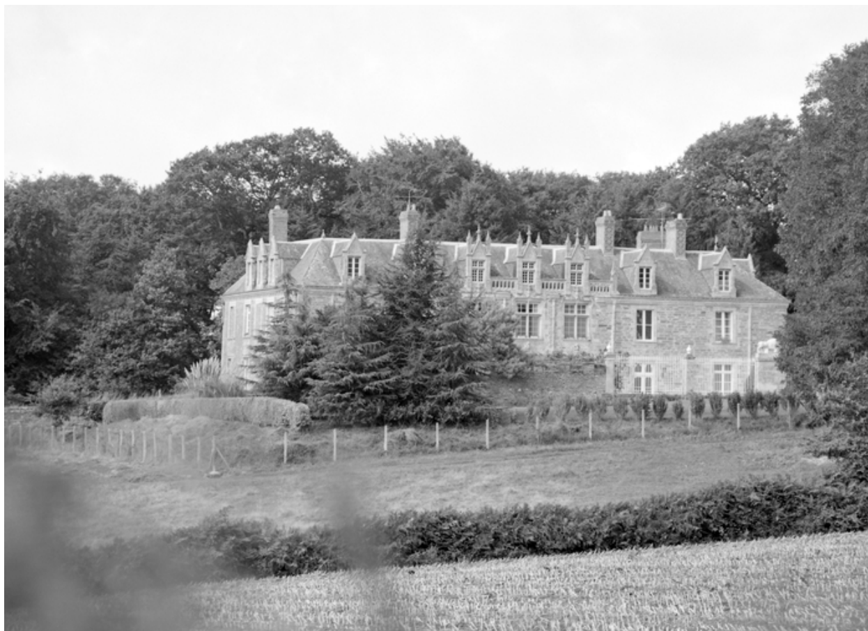
Vue de situation prise du sud-est
