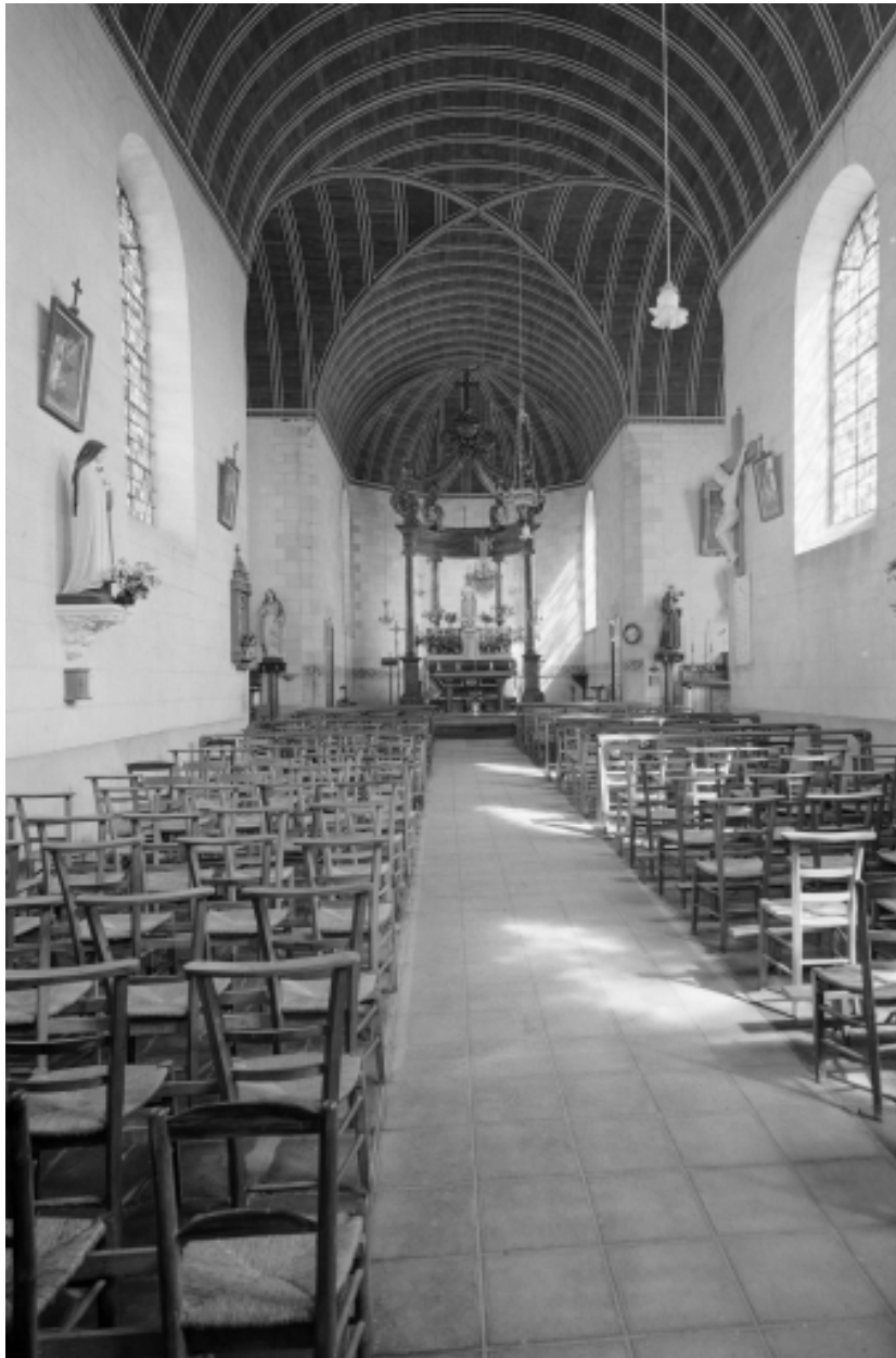
Intérieur : vue générale vers le chœur.
