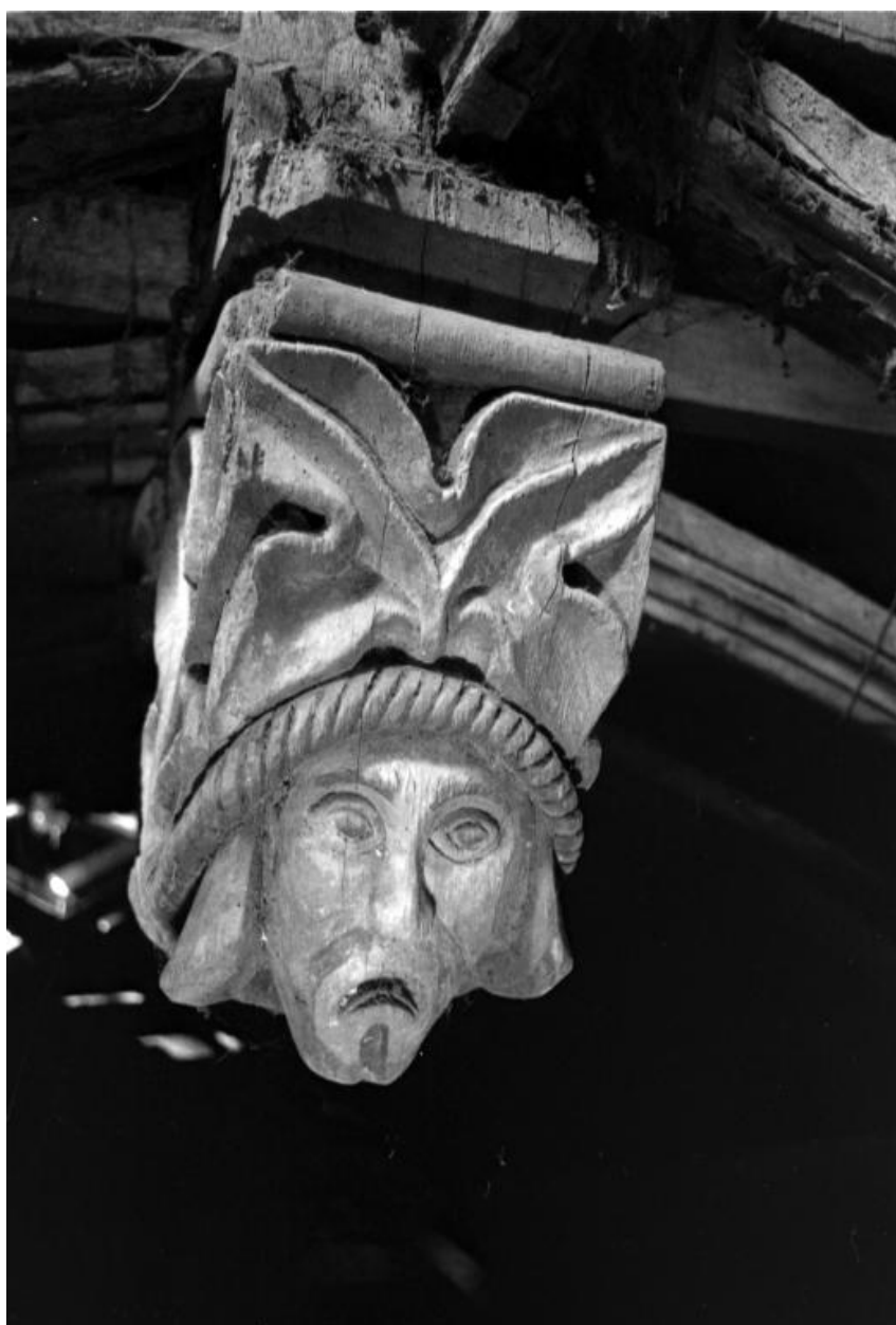
Charpente, détail de la clé 26.
