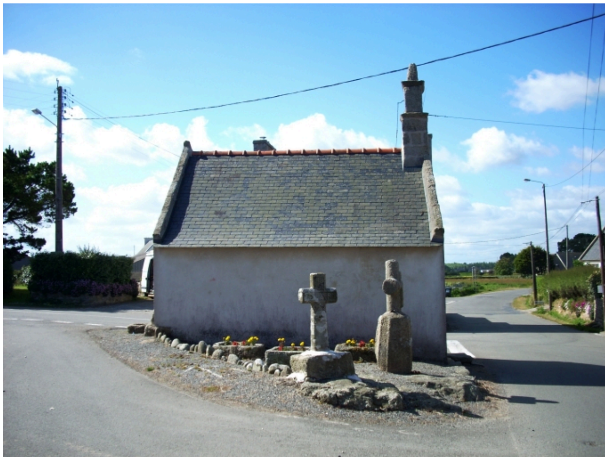
Kerlouan, chapelle Notre-Dame du Croazou : élévation nord
