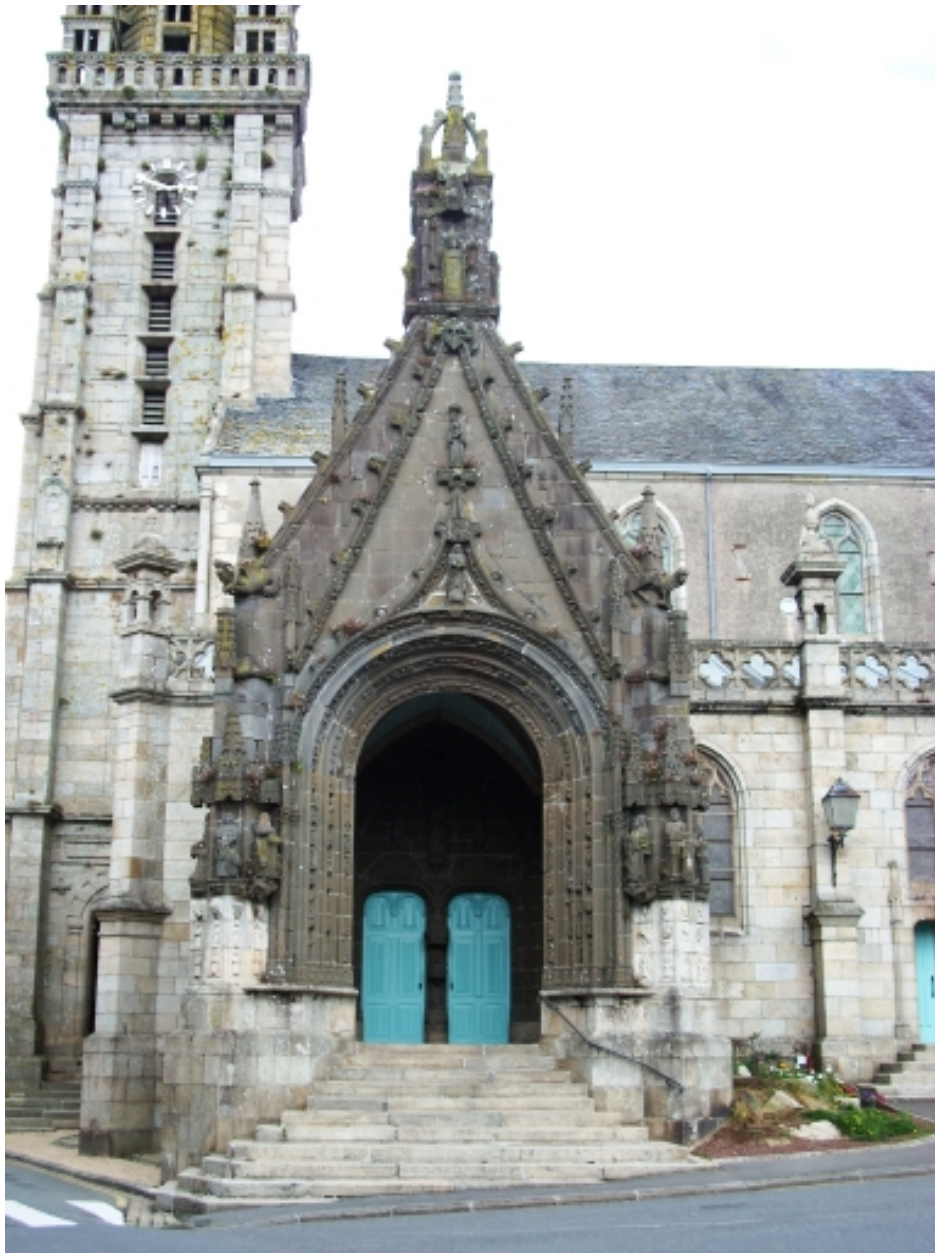
Landivisiau, église paroissiale Saint-Thuriau : porche sud, détail
