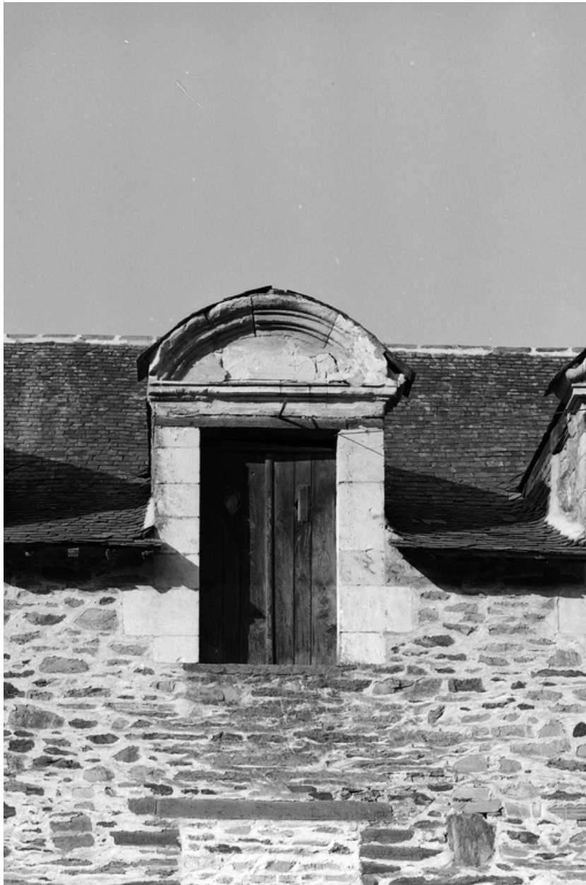
Façade, partie centrale, vue de détail d'une lucarne.
