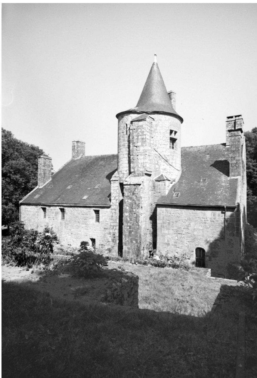
Logis, élévation postérieure : vue générale prise du sud ouest
