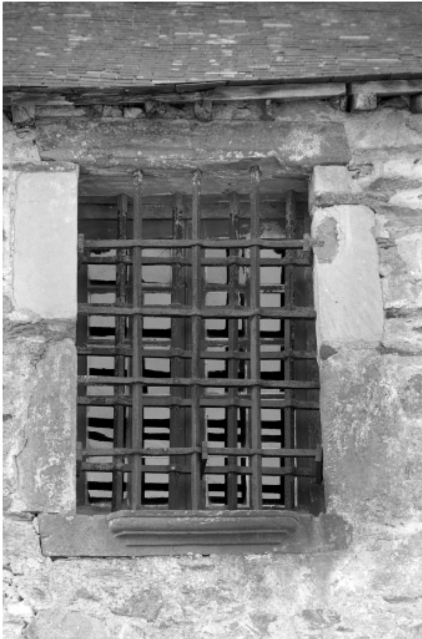
Sacristie, face est, grille de la fenêtre.
