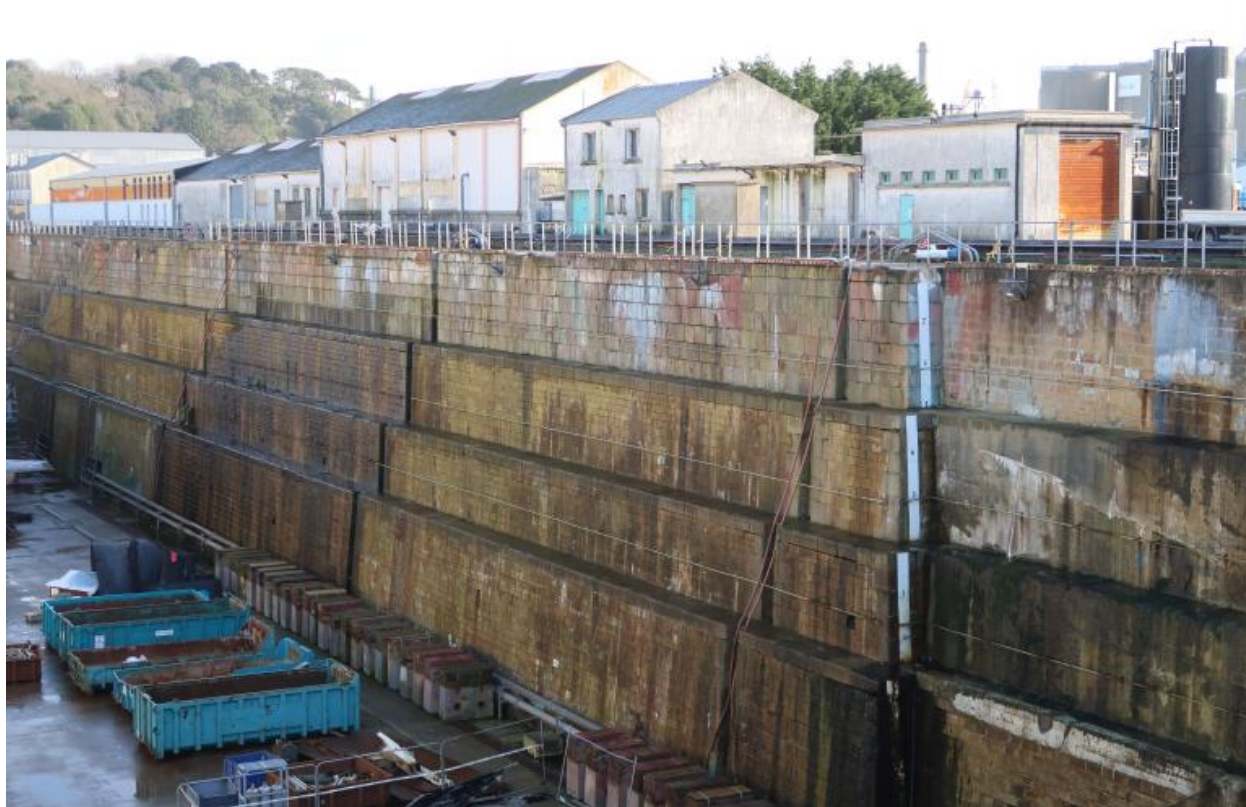
Forme 1, bajoyer sud : banquettes, pierre de taille de Logonna ; bâtiment administratif de l'antenne portuaire en arrière plan
