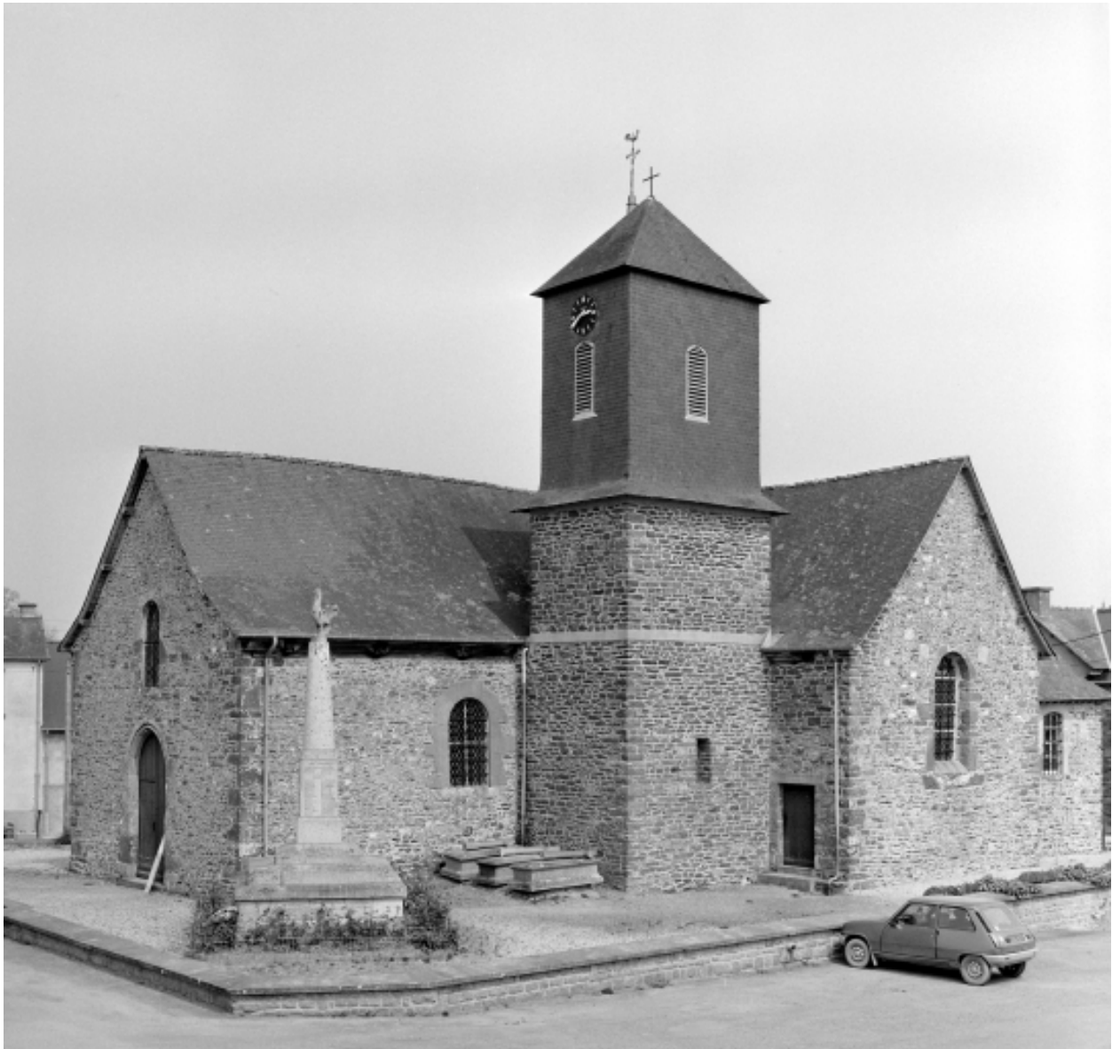
Elévation Sud-Ouest : vue générale
