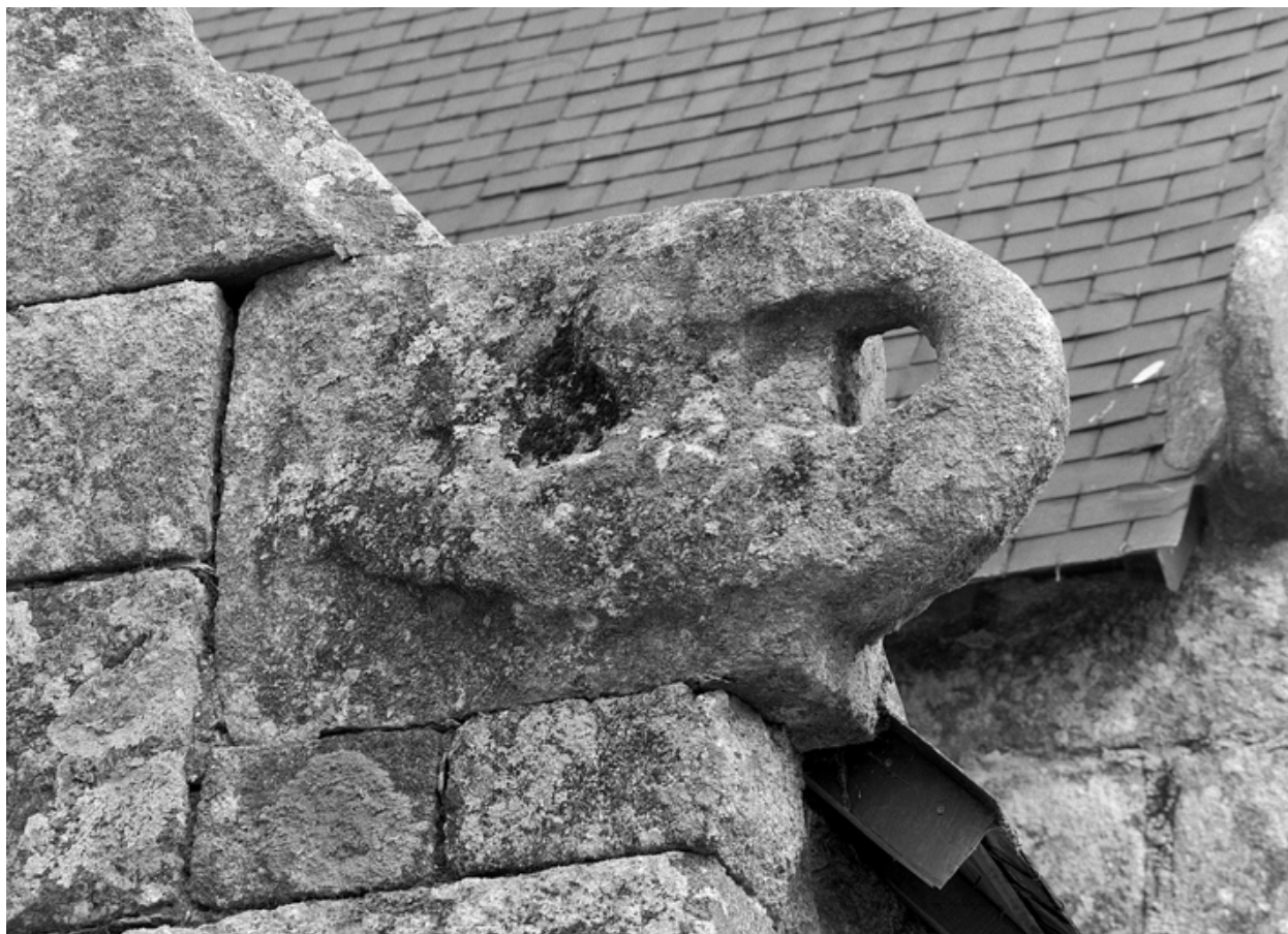
Croisillon sud, face sud : détail du corbeau est des rampants
