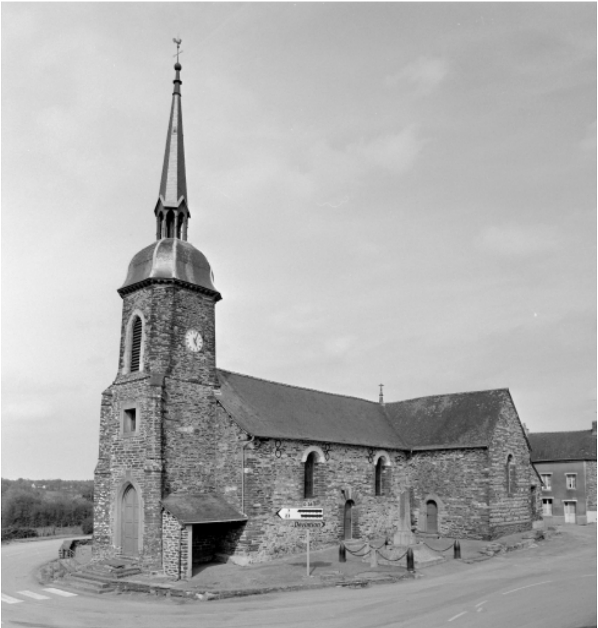
Elévation Sud-Ouest : vue générale
