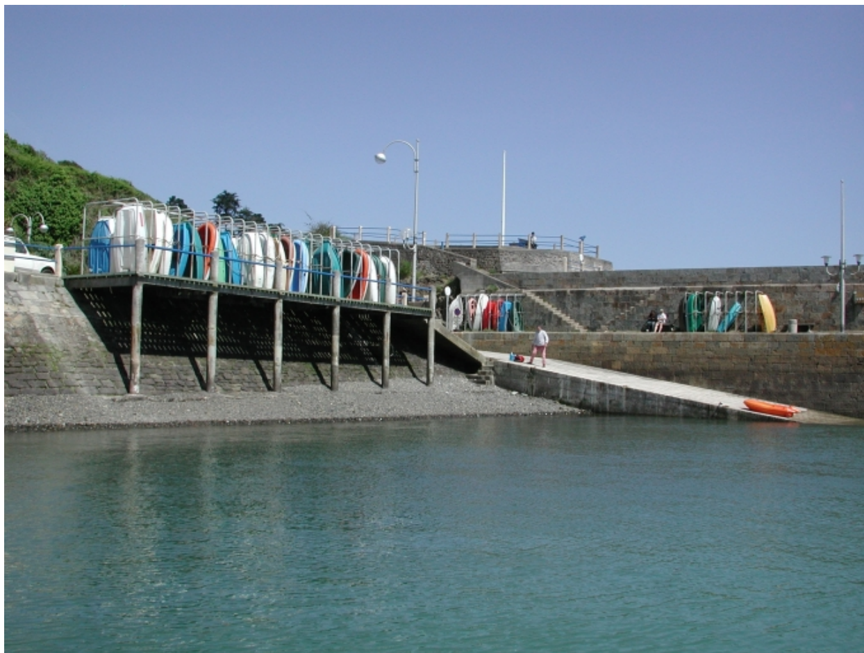
Vue de l'extrémité du quai Surcouf : remarquer le ponton aux annexes sur pilotis et la cale
