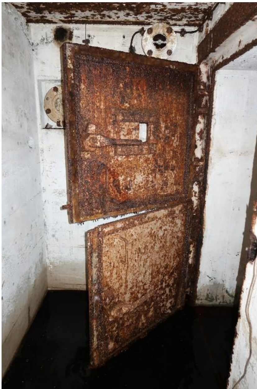
Vue intérieure : petite pièce située au nord-est, porte blindée à deux vantaux
