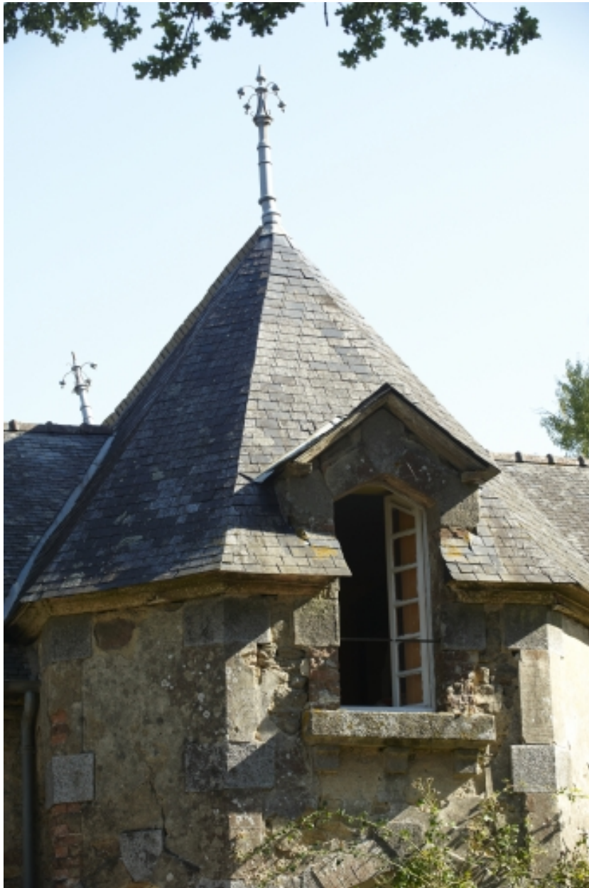
Partie centrale des communs, détail
