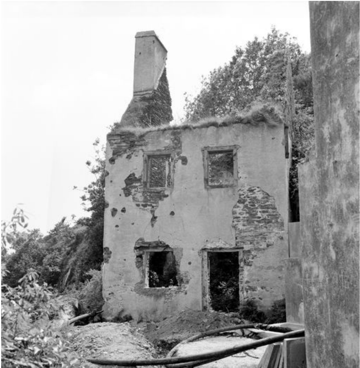
Vue de la batterie de la pointe des Espagnols en 1969 : bâtiment ruiné de la batterie basse
