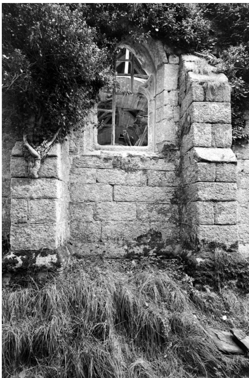
Vue de la fenêtre du mur sud du bras sud
