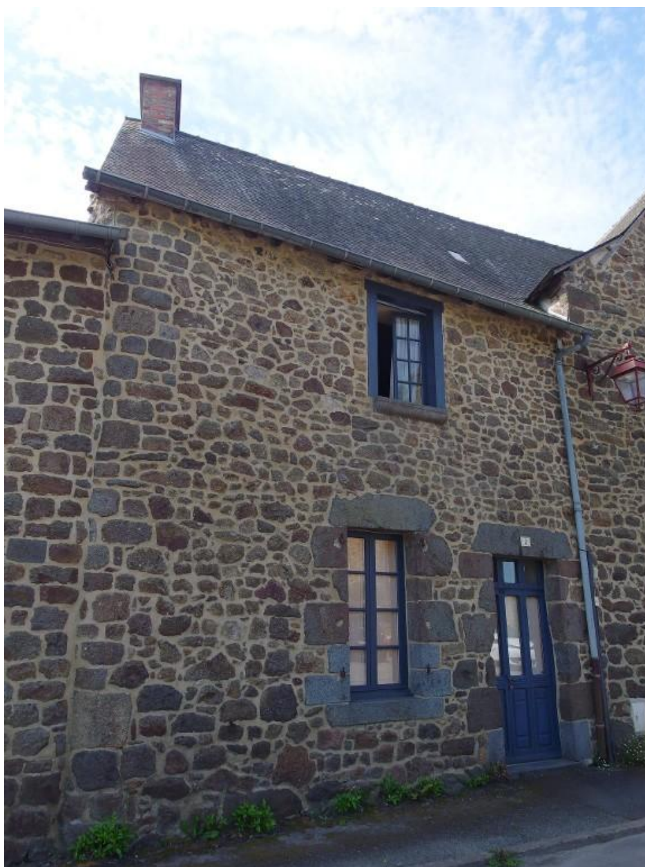
Vue de la façade nord
