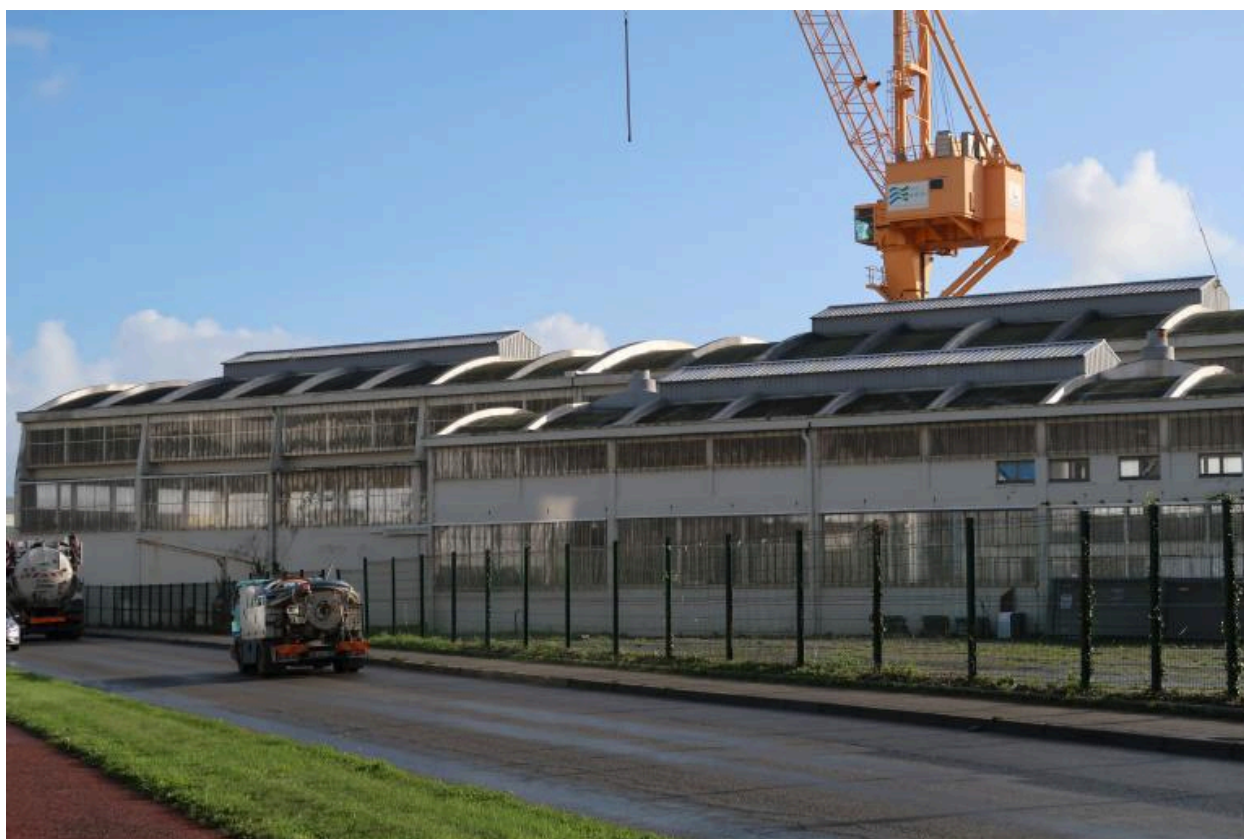
Hangar de réparation, ancien atelier Dubigeon, façade nord
