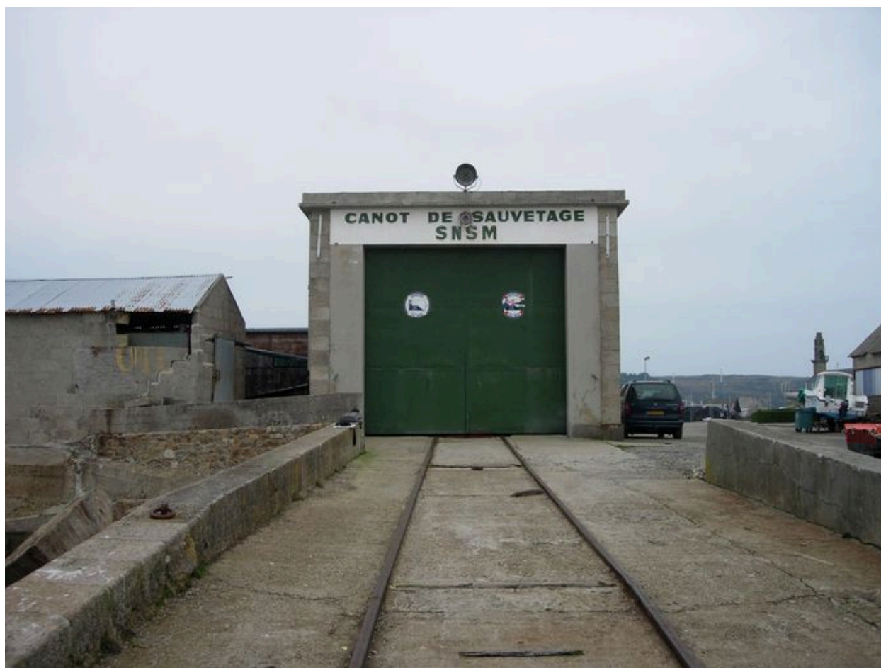
Vue générale de l'abri du canot de sauvetage
