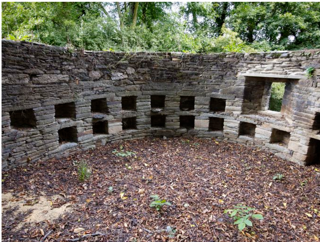
Château, ancienne enceinte au nord : intérieur du colombier (état en 2010)
