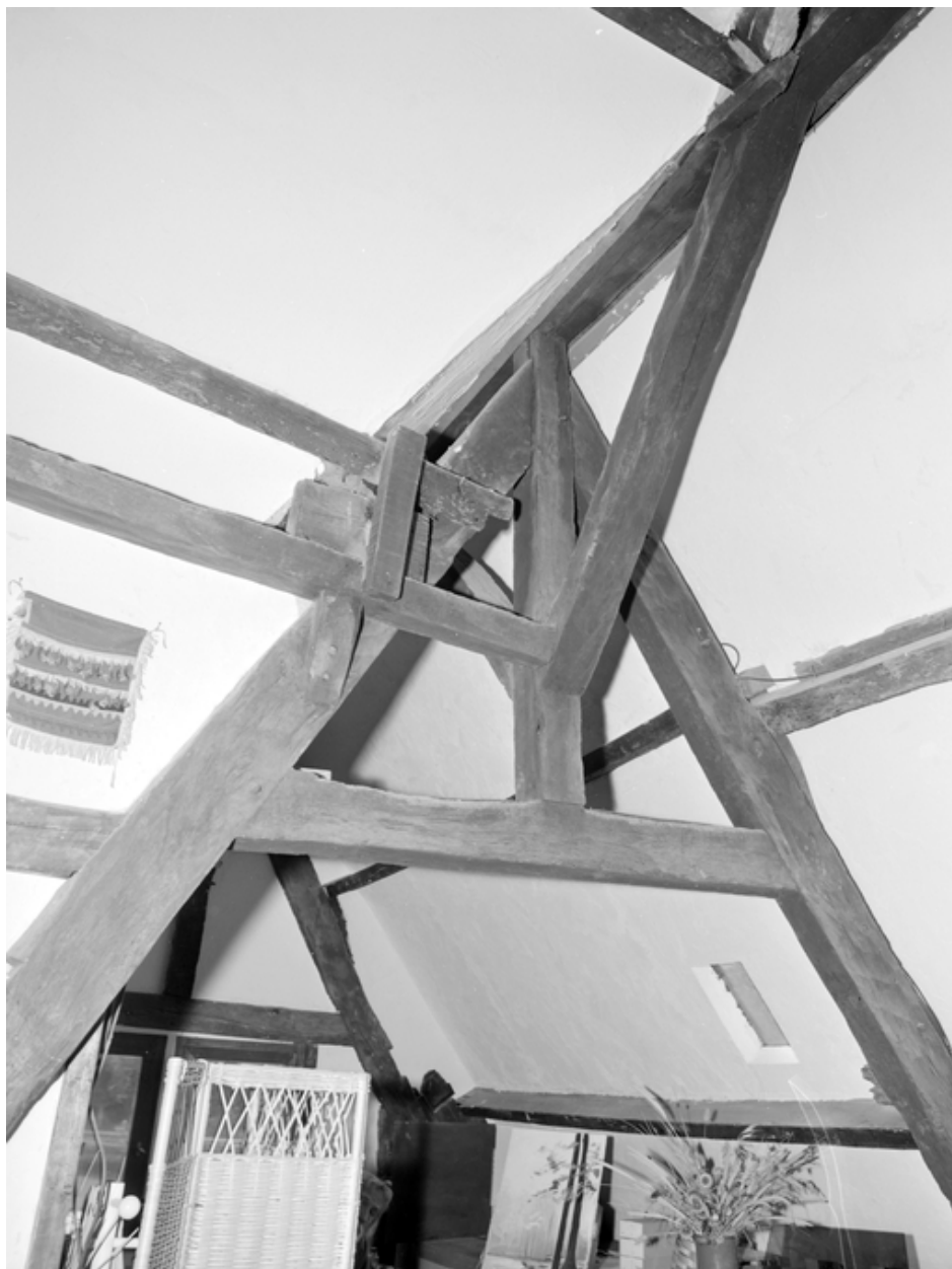
Charpente, ferme intermédiaire avec noue du toit perpendiculaire (1978).
