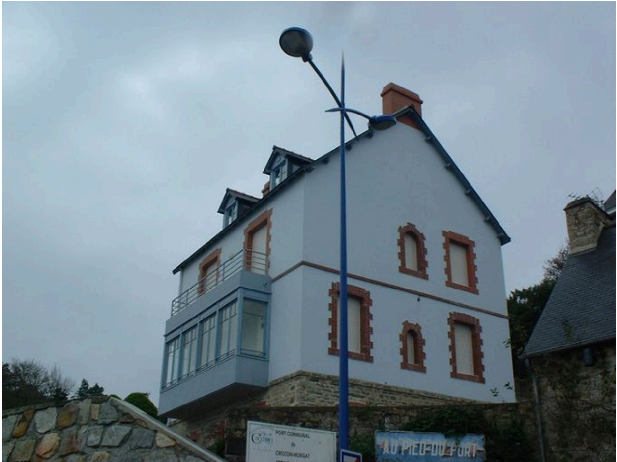
Vue de trois-quarts d'une maison de conservateur, côté mer
