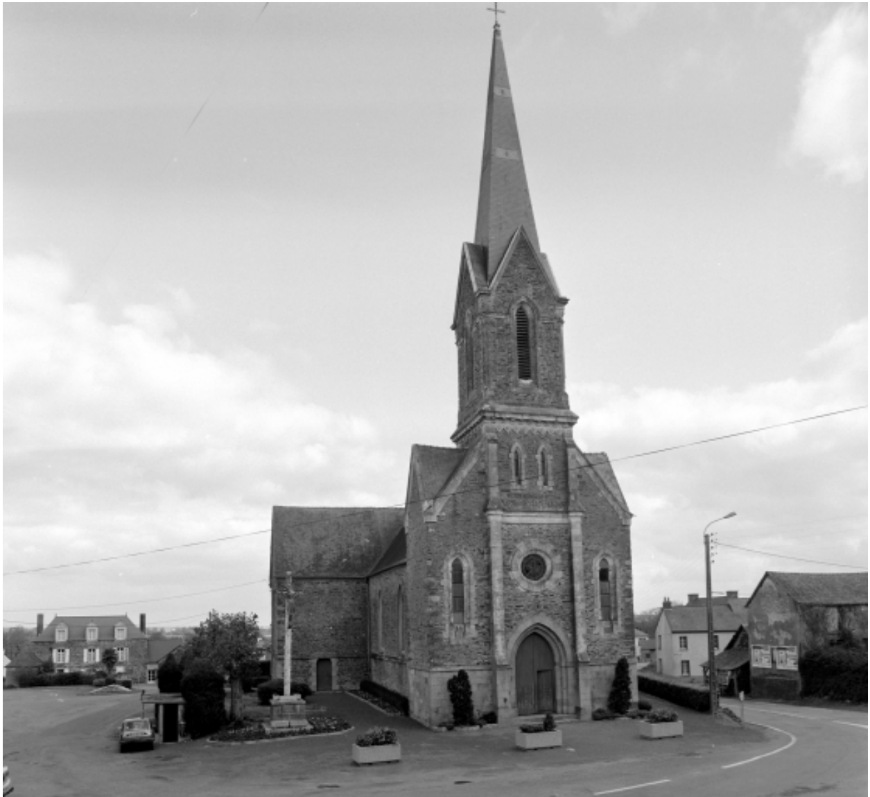
Elévation Sud-Ouest : vue générale
