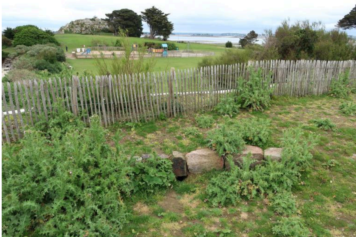
Vue de la plate-forme sommitale du four : emplacement du gueulard de chargement du calcaire et du combustible (état en 2023)
