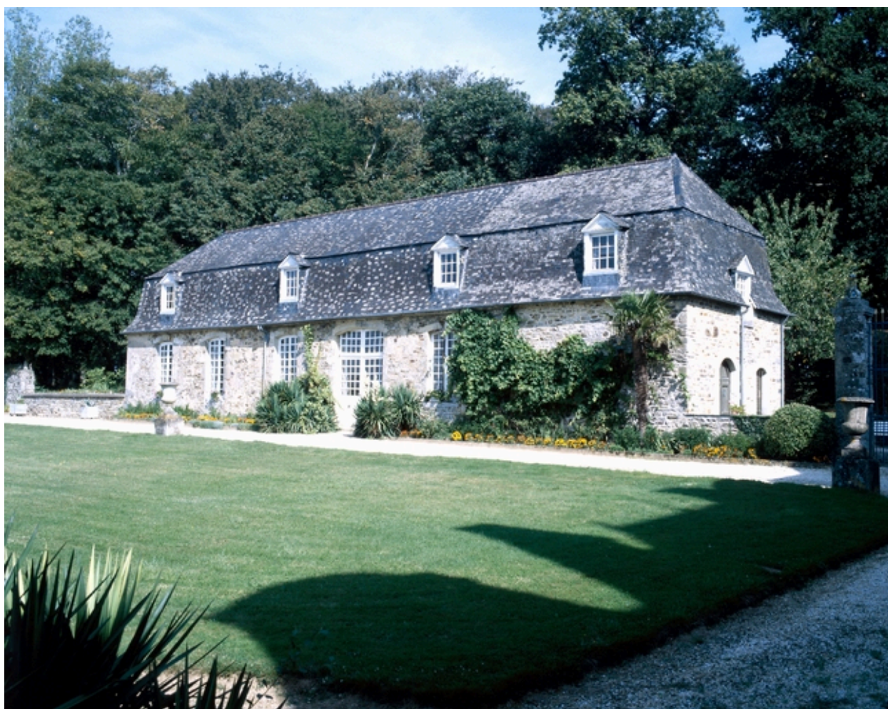
Orangerie, vue générale.
