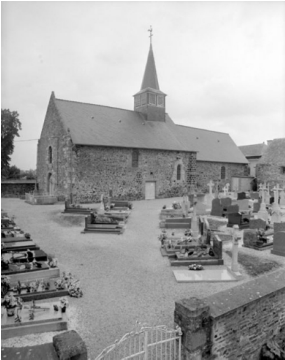
Vue générale : élévation sud
