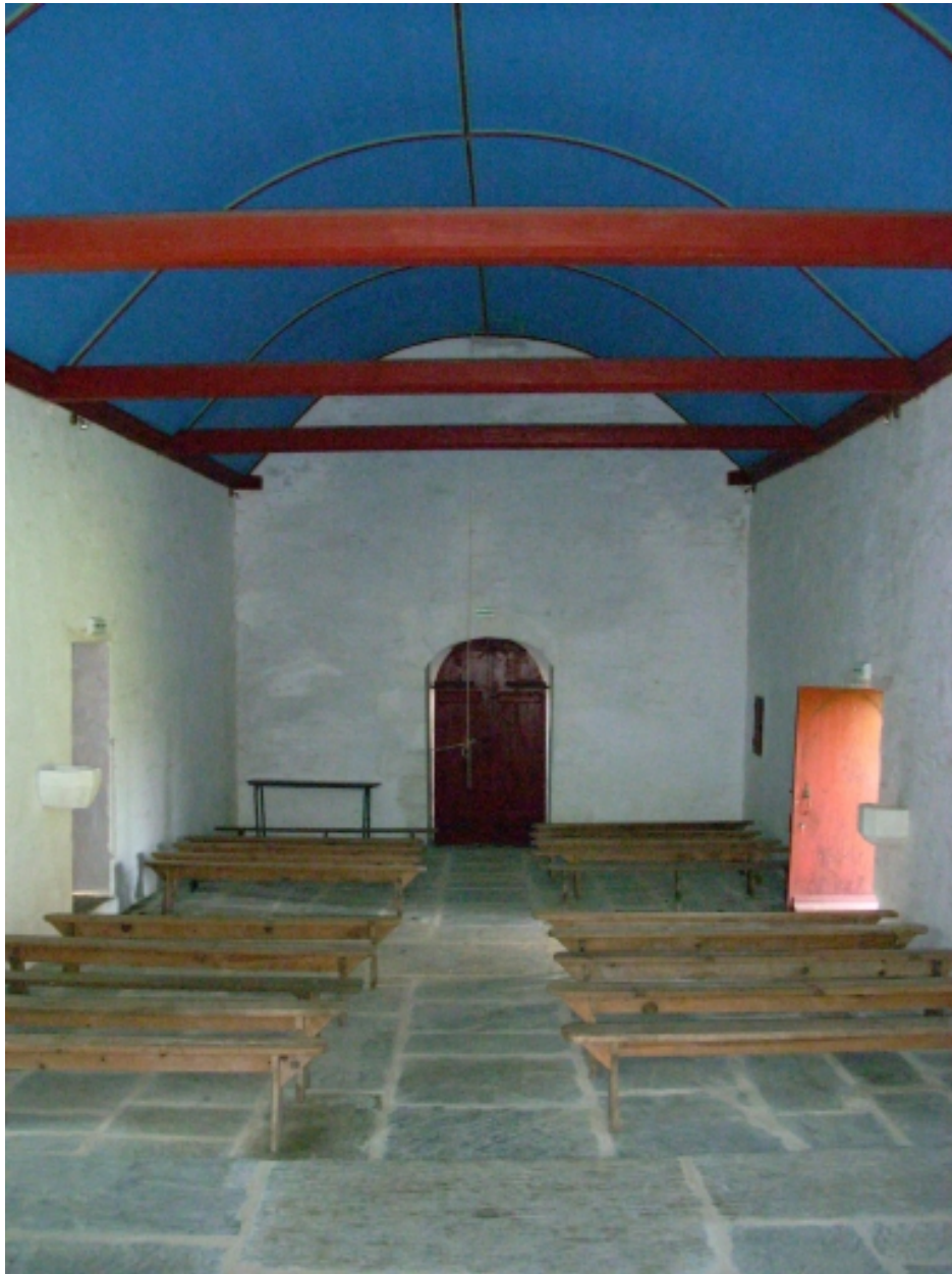
Saint-Thois, chapelle Saint-Laurent : vue axiale ouest
