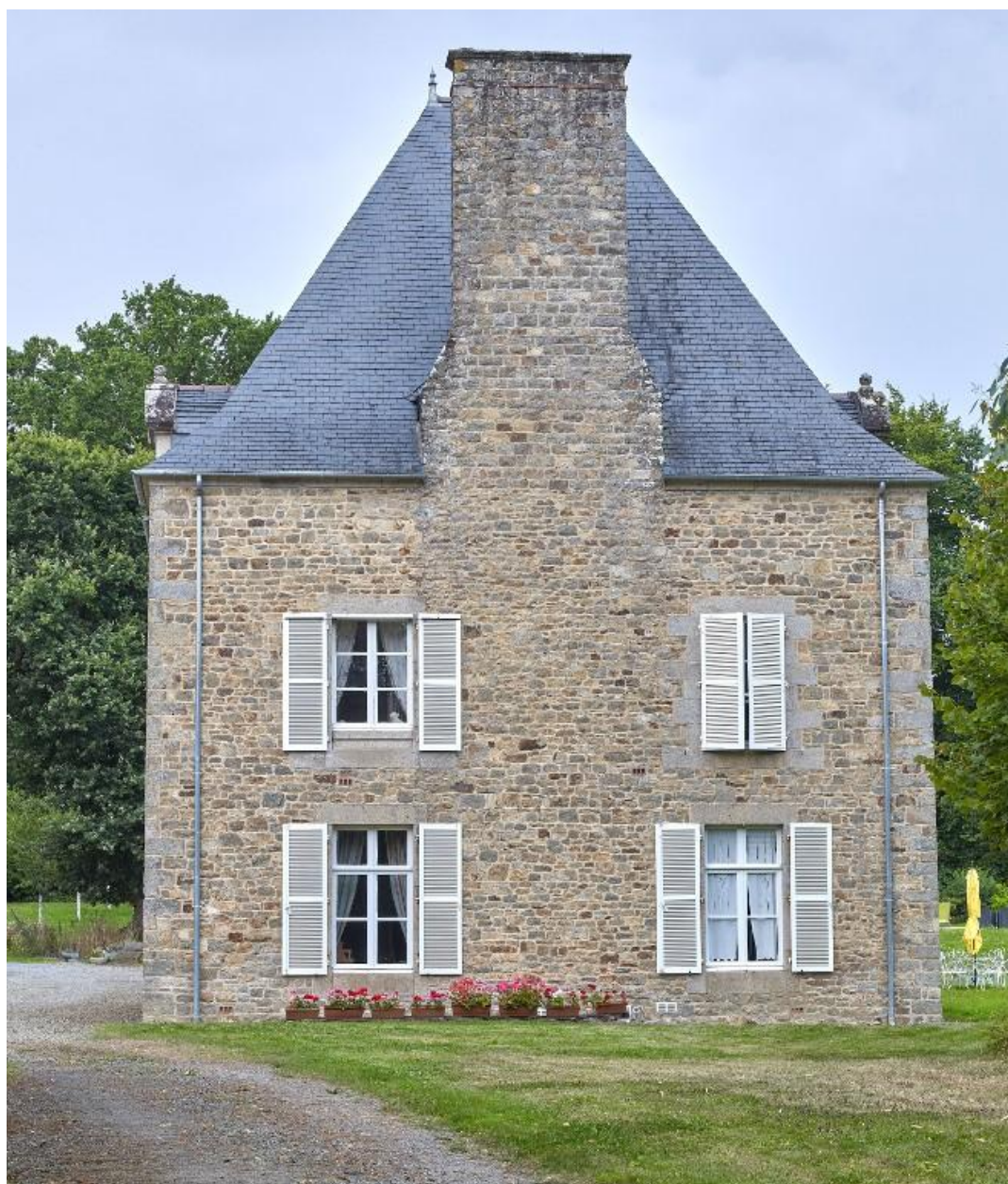
Façade orientale du pavillon est.
