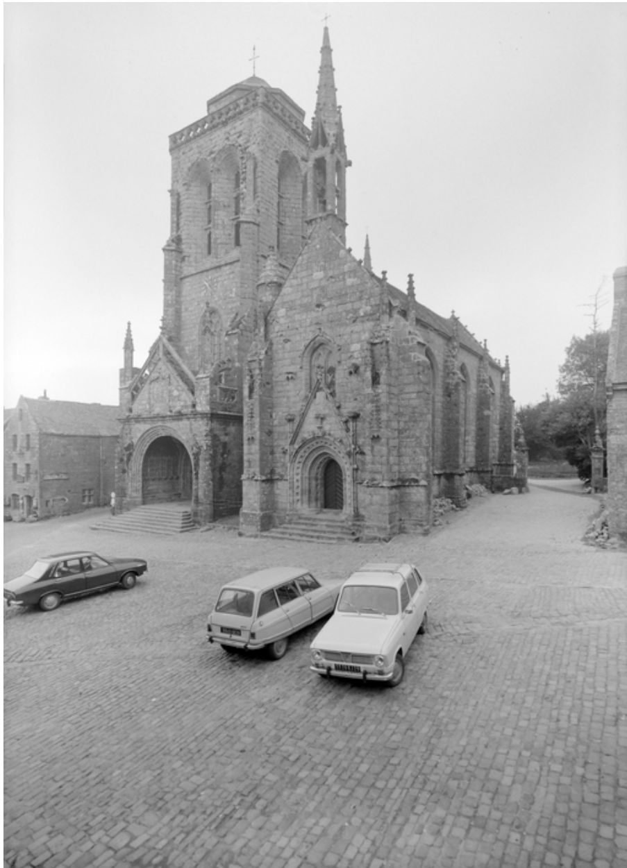
Façade ouest, vue générale
