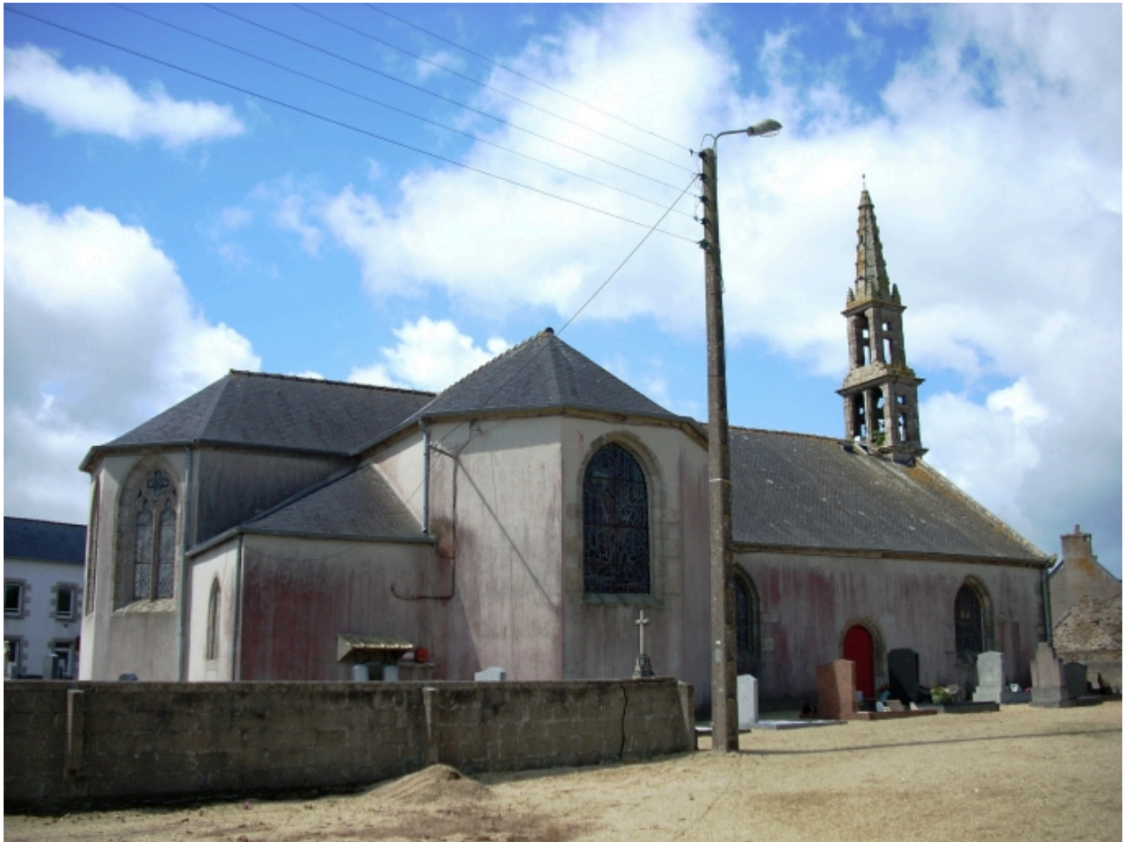
Saint-Derrien, église paroissiale Saint-Derrien : vue générale nord-est
