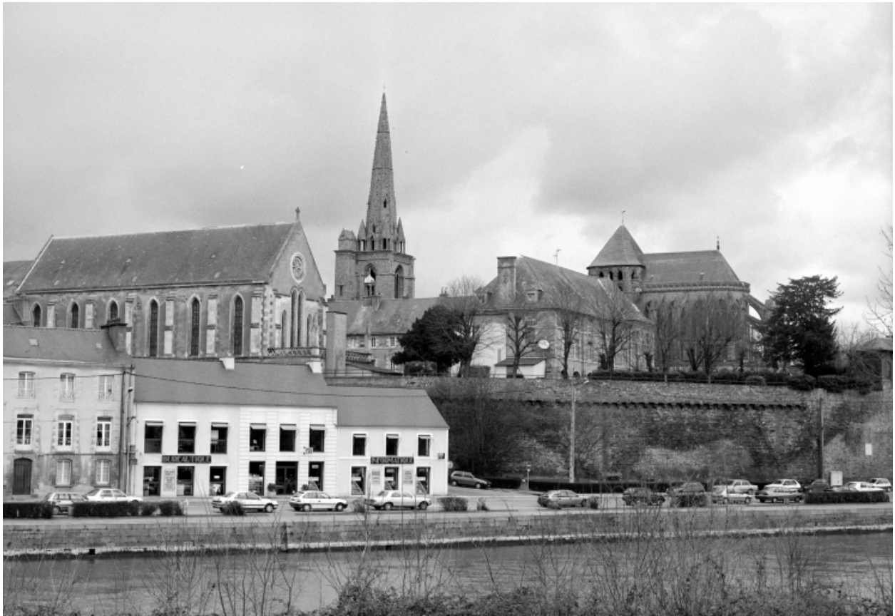
Elévation Sud-Ouest : vue de situation
