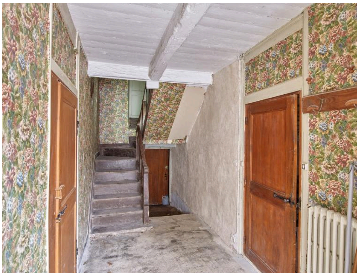
Vestibule d'entrée avec portes d'accès à l'appentis nord. Vue générale
