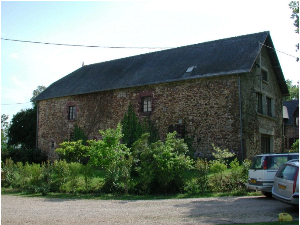
Vestige du manoir ; vue générale nord-est
