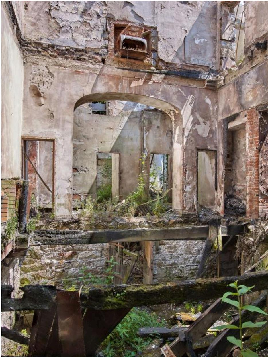
Vue intérieure : salle située au Nord-ouest, mur de refend percé d'ouvertures. Les planchers ont cédé lors de l'incendie laissant apparaître le sous-sol. A l'étage, un poêle est resté en place dans sa cheminée
