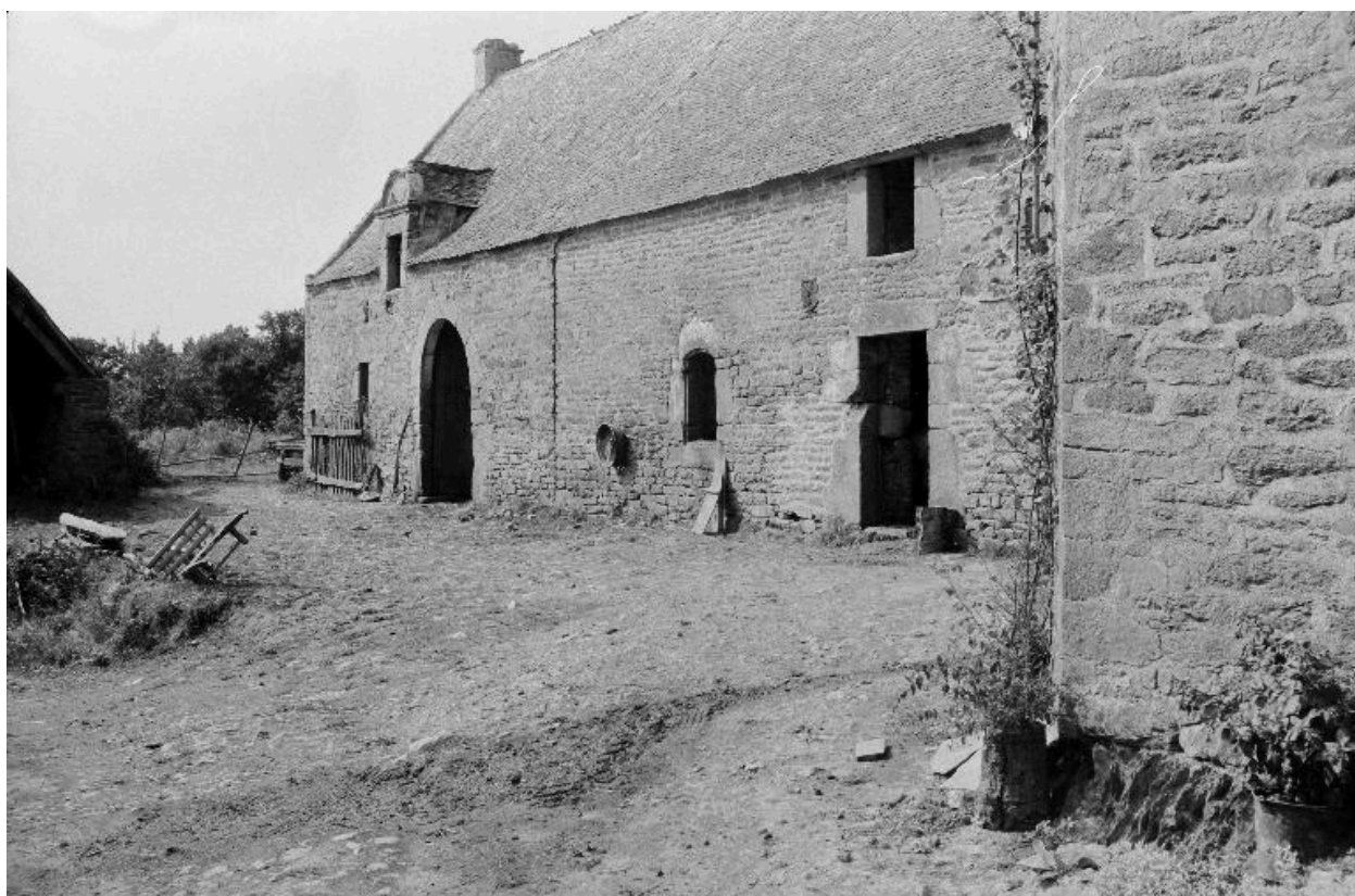
Ferme 45 : à gauche, la porte de la grange (état en 1969)
