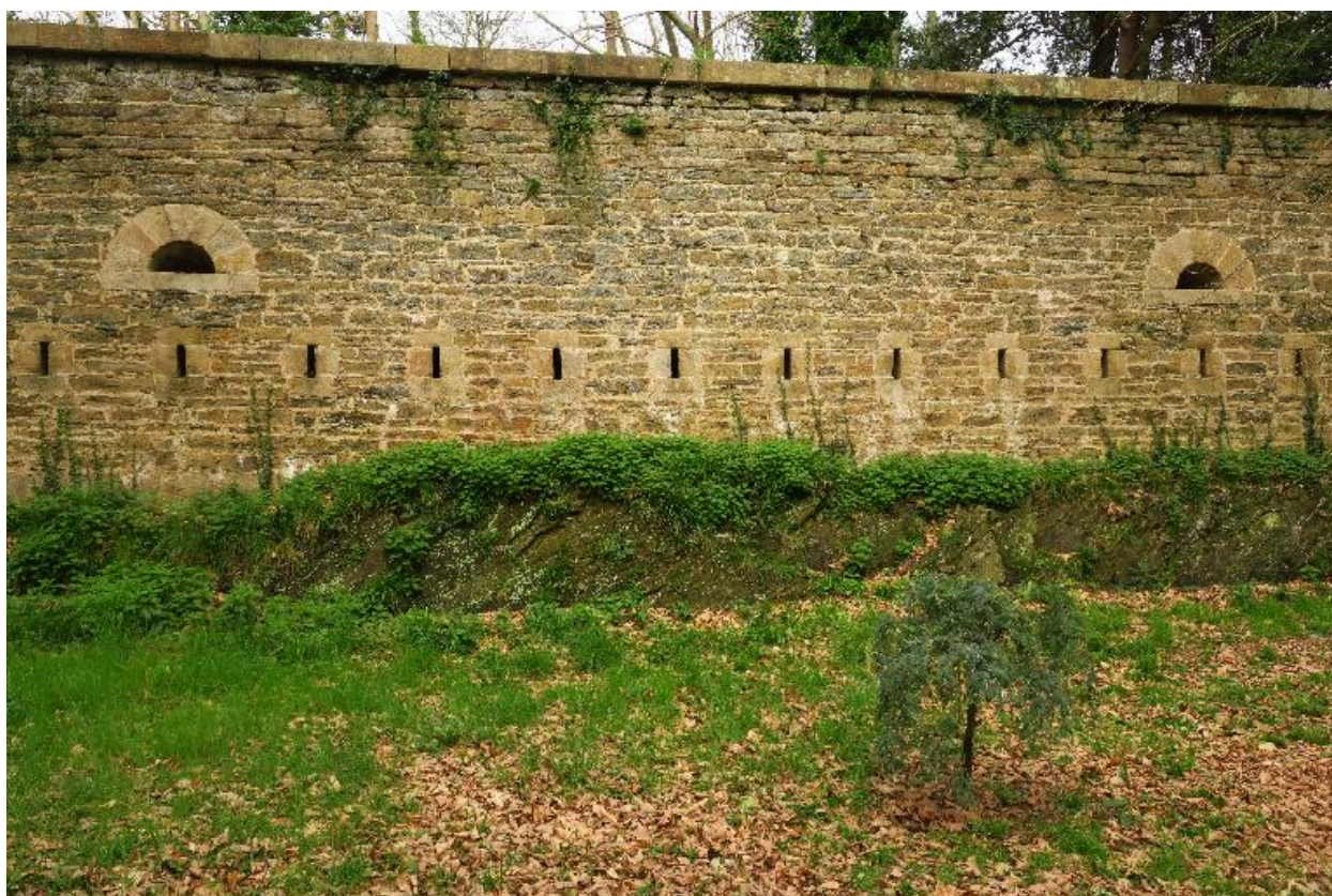
Le Palais, enceinte urbaine, galerie de contrescarpe, extrémité droite.
