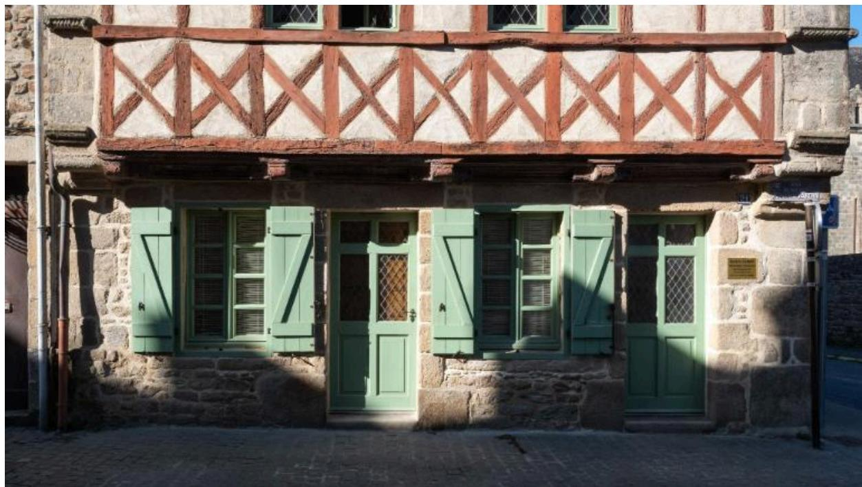
Reprise en sous-œuvre du rez-de-chaussée, dont la maçonnerie est postérieure à l'édifice d'origine.
