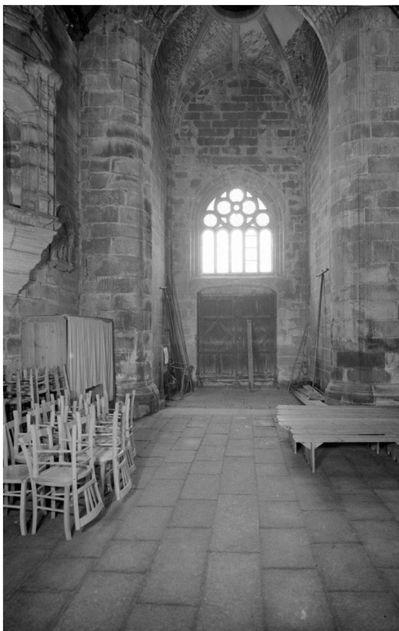
Rez-de-chaussée de la tour : mur ouest
