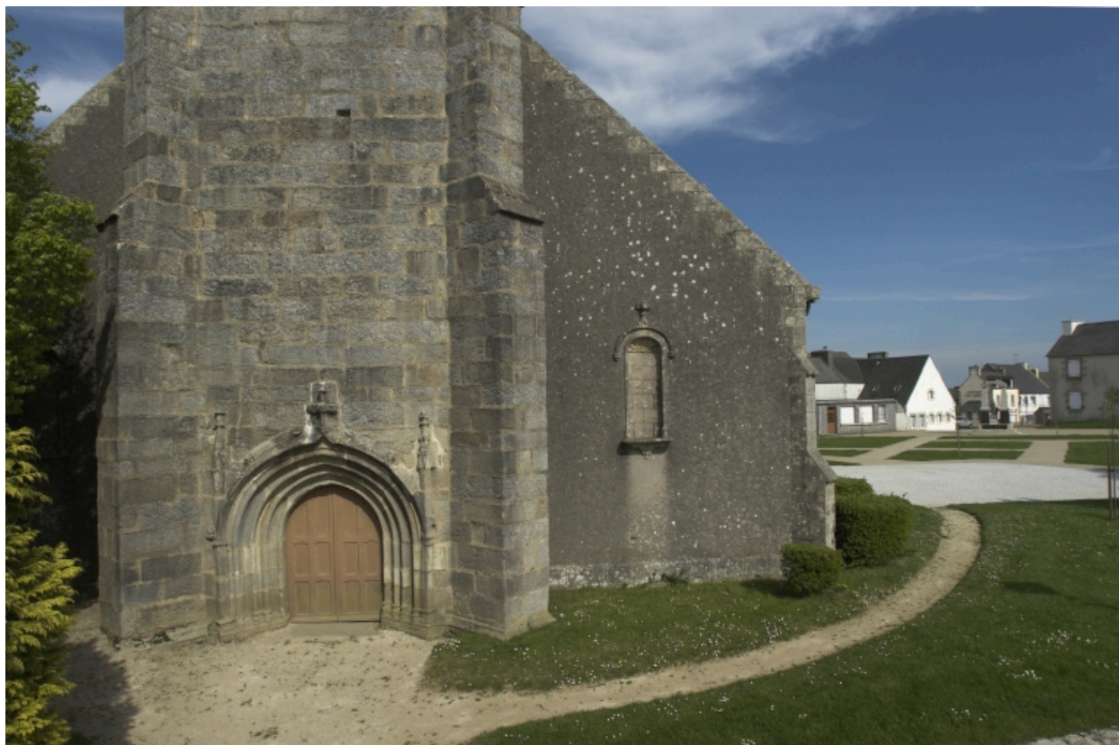
Scrignac, église paroissiale Saint-Pierre : façade ouest, état en 2007
