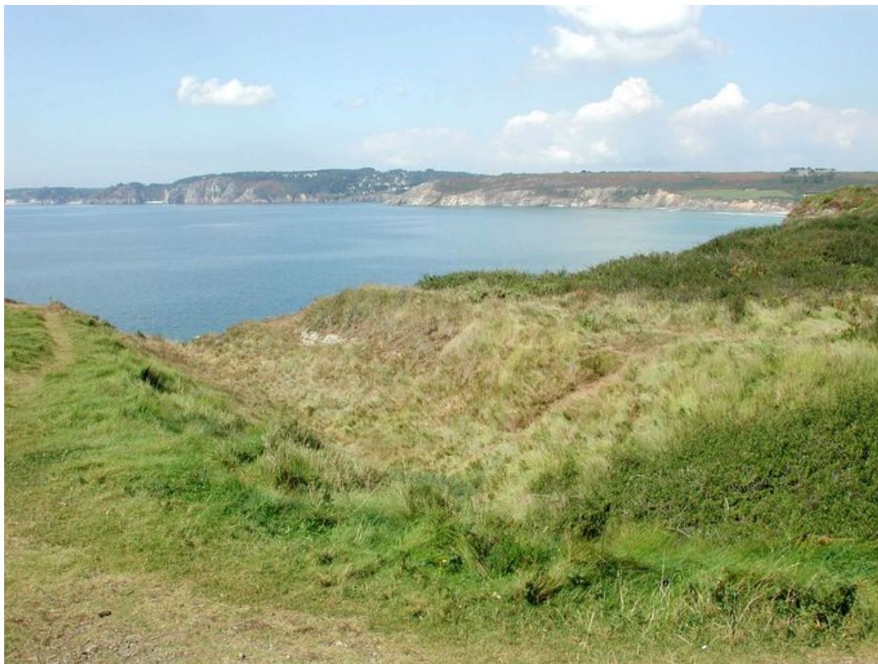
Vue du réduit de batterie de côte de l'île de l'Aber : fossé sec situé en avant du réduit
