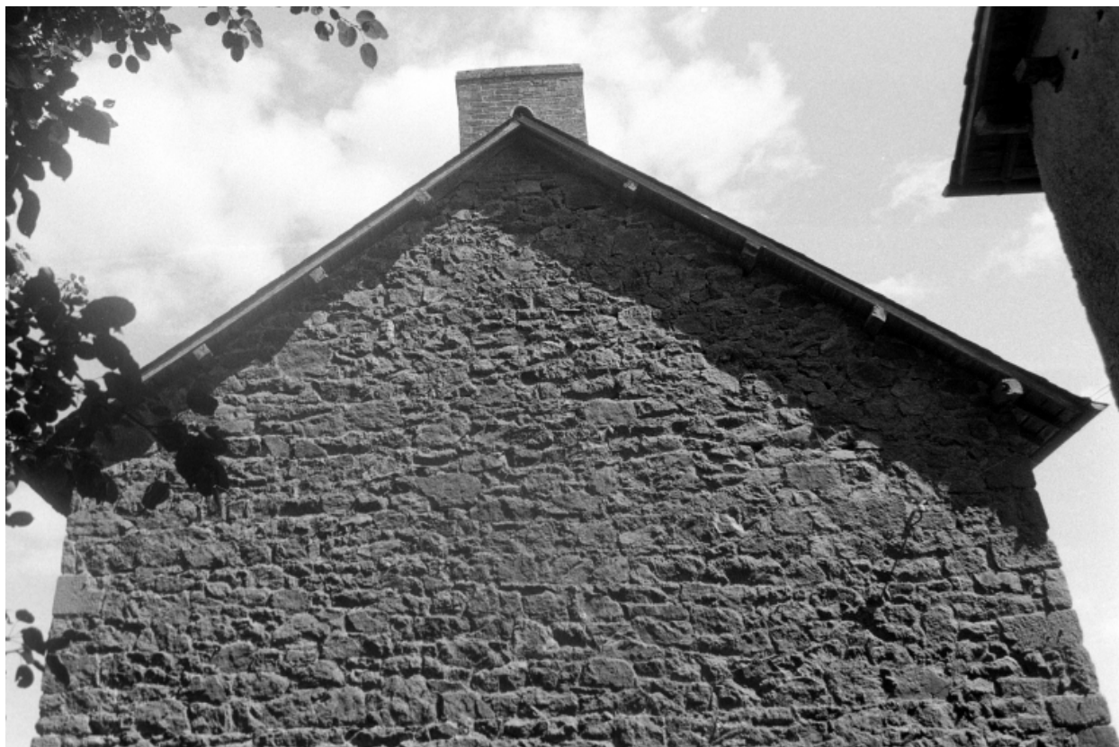
Pignon du logis
