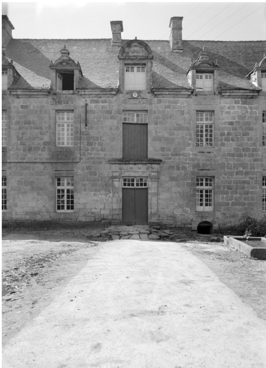
Détail des trois travées centrales
